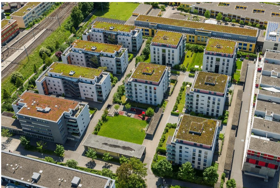
Abbildung 16: Begrünte Dächer (hier im Quartier Bahnmatt in Baar) wirken kühlend (Foto: Andreas Busslinger)
