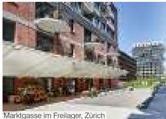
Marktgasse im Freilager, Zürich
