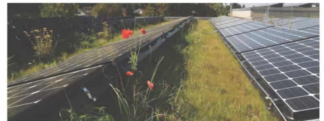
Dachbegrünung mit Photovoltaik-Anlage © Dr. Stephan Brenneisen (Referenzbilder)
