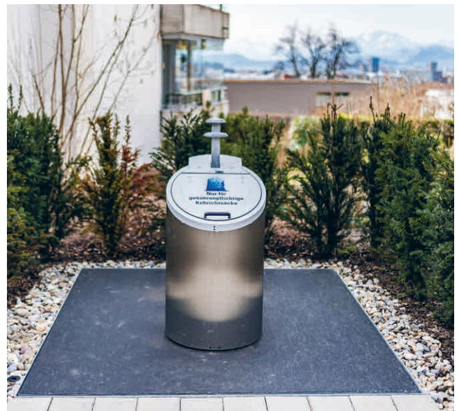
In die Umgebung eingebettete UFC-Anlage mit einer Einwurfsäule
