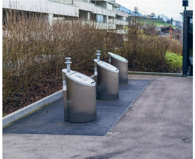
UFC-Anlage mit drei Einwurfsäulen
